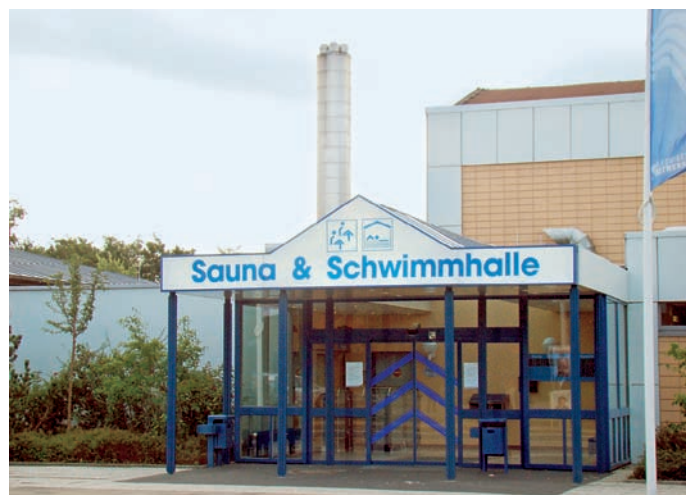
Die Schleswiger Schwimmhalle, im Hintergrund der Schornstein des Blockheizkraftwerkes, soll nach dem Willen der Ratsmehrheit abgerissen werden.
